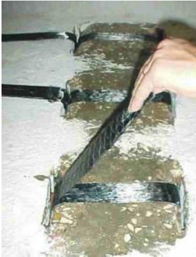
تقویت برشی تیرها توسط ورق های FRP دو طرفه
