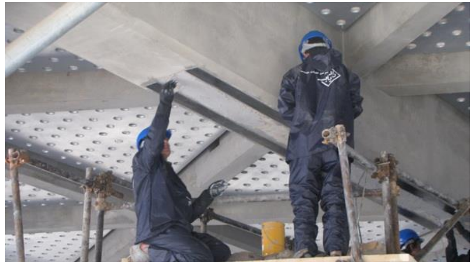
تقویت خمشی تیرها توسط ورق FRP
